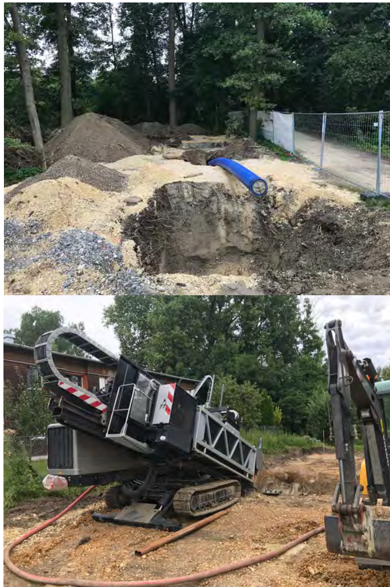
Donaudücker entlang der B16, beide Seiten der Baustelle
