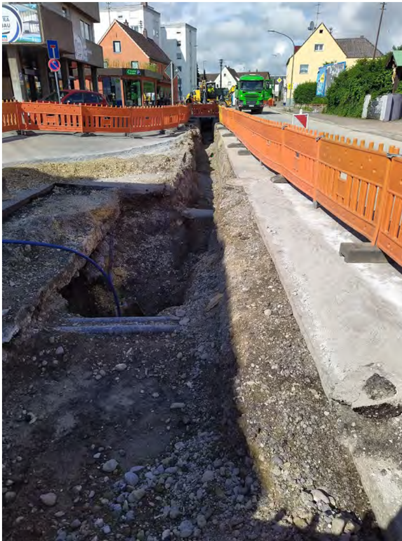
Baustelle Kreuzung Weißenhornerstr. / Ulmerstr.
